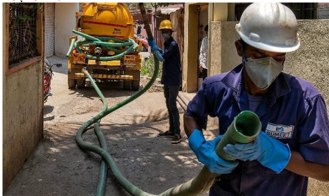
Hình 5 Người điều khiển xe tải và người trợ giúp lắp đặt đường ống bơm chân không từ xe tải đến bể tự hoại ở Wai.
