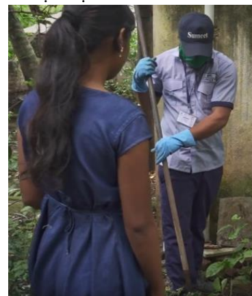
Hình 8 Máy hút bùn kiểm tra độ sâu bùn 25mm còn sót lại trong bể tự hoại sau khi hút bùn
