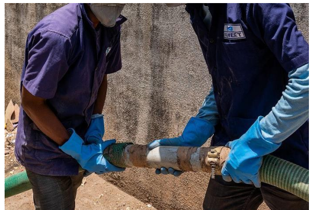
Hình 6 Nếu như các khoảng cách từ các máy hút bụi xe tải vào bể tự hoại dài, hai hoặc ba ống
