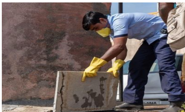
Hình 10 Sau khi hút bùn, nắp bể tự hoại bể được thay thế bằng một nắp dễ mở
