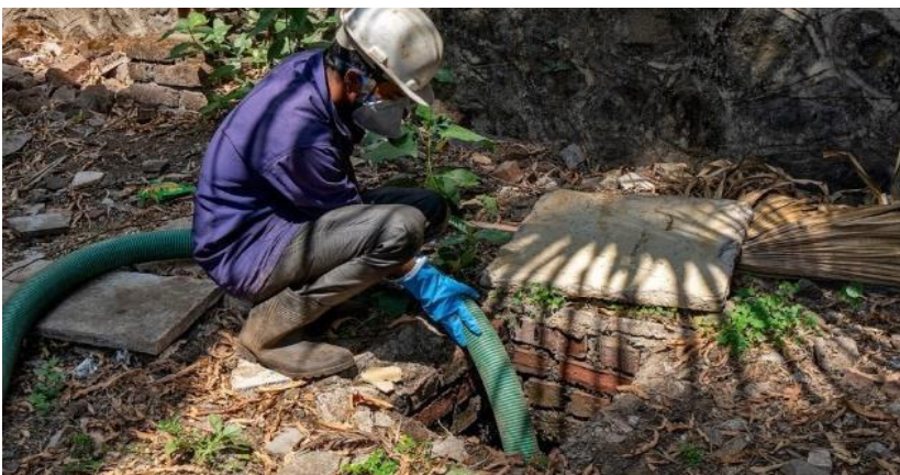
Hình 7 Người vận hành máy bơm trộn bùn trong khi thực hiện hoạt động hút bùn ở Wai
